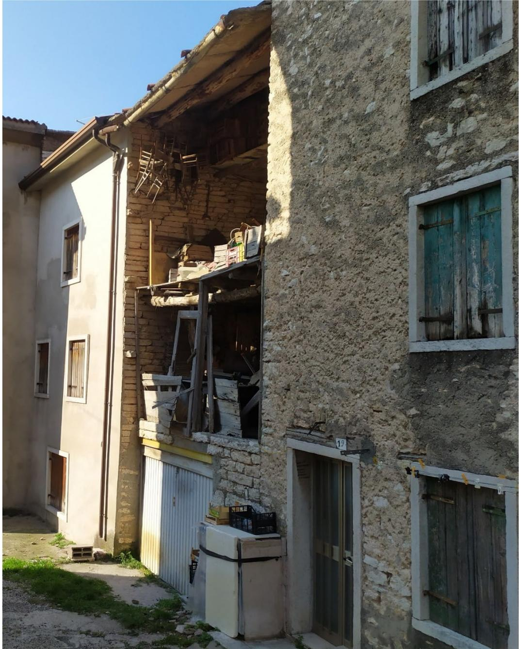
*Figura 10 - Dettaglio del collegamento in semplice battuta sul muro est tra la porzione 1 e 3. Si nota il gradino che si è creato edificando il muro 3 in allineamento con quello della porzione 2.*
